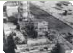
Іл. 36.10. Аварія на Чорнобильській АЕС
