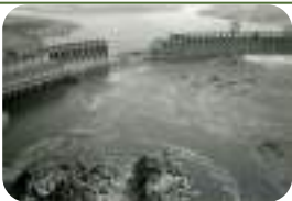
Іл. 33.8. Зруйнована вибухом гребля Дніпрогесу в 1941 р.
