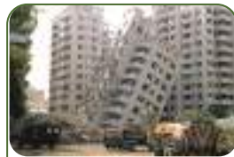
Іл. 33.15. Наслідки землетрусу
