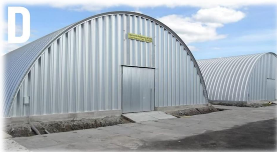
Рис.2.4. Зовнішнє облаштування складського приміщення класу D
